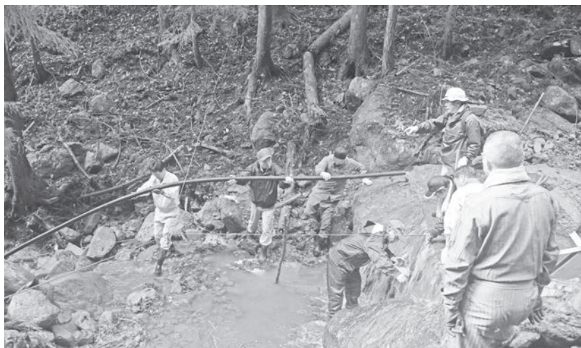
写真7 オクヤマでの増設パイプ設置作業
